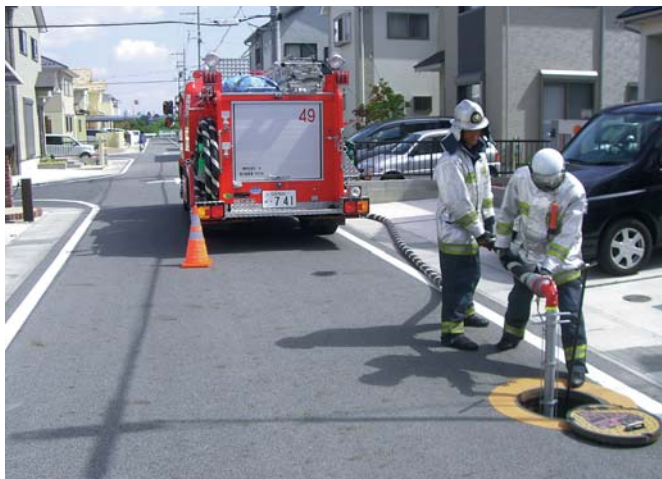
消火栓は、消防車が吸水しやすいように、道路脇や歩道上に設置されています。消火栓など、消防水利の周辺の駐車が禁止されている場所への駐車はやめましょう。
