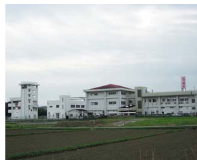
宮崎市消防総合訓練施設 (南消防署)
